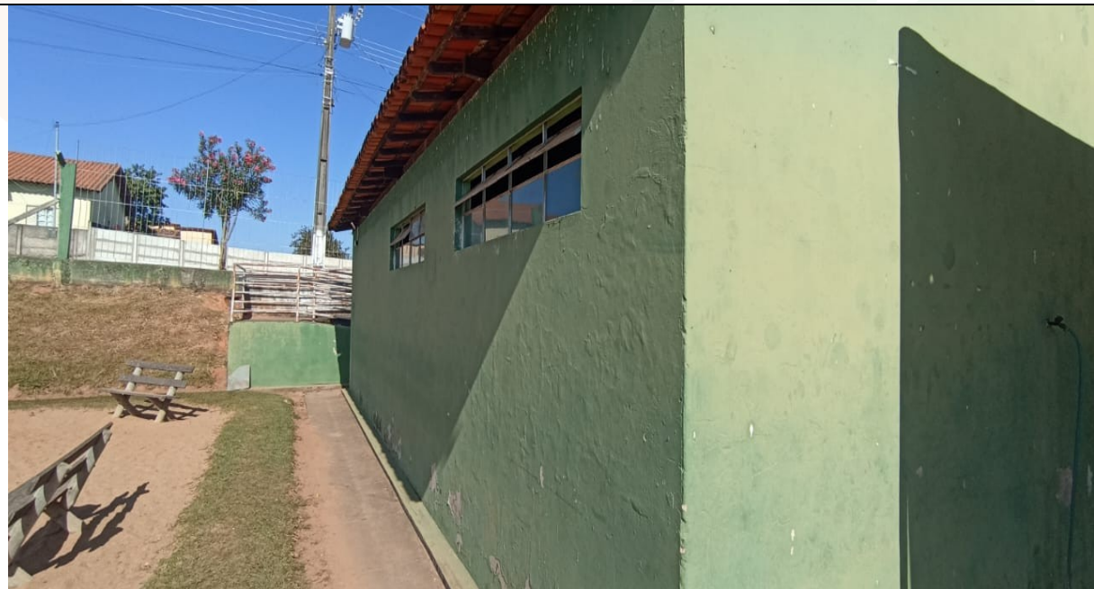
IMAGEM 04 – VISTA EXTERNA DOS VESTIÁRIOS
